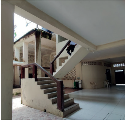
Vías de difícil acceso y ubicación a la comisaría de Lloró
